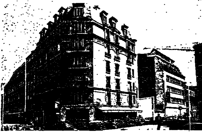
Les façades du futur siège du Monde s'ouvrent l'une sur la rue Falguière, l'autre sur la rue Bourdelle.
